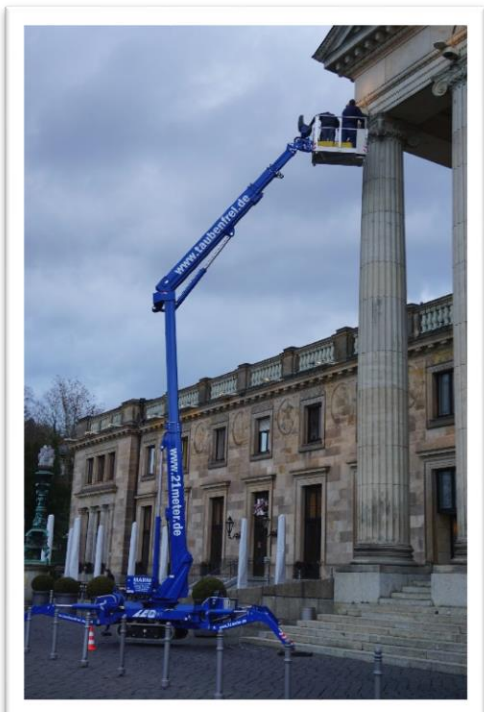
Arbeitshöhe bis 21 Meter
